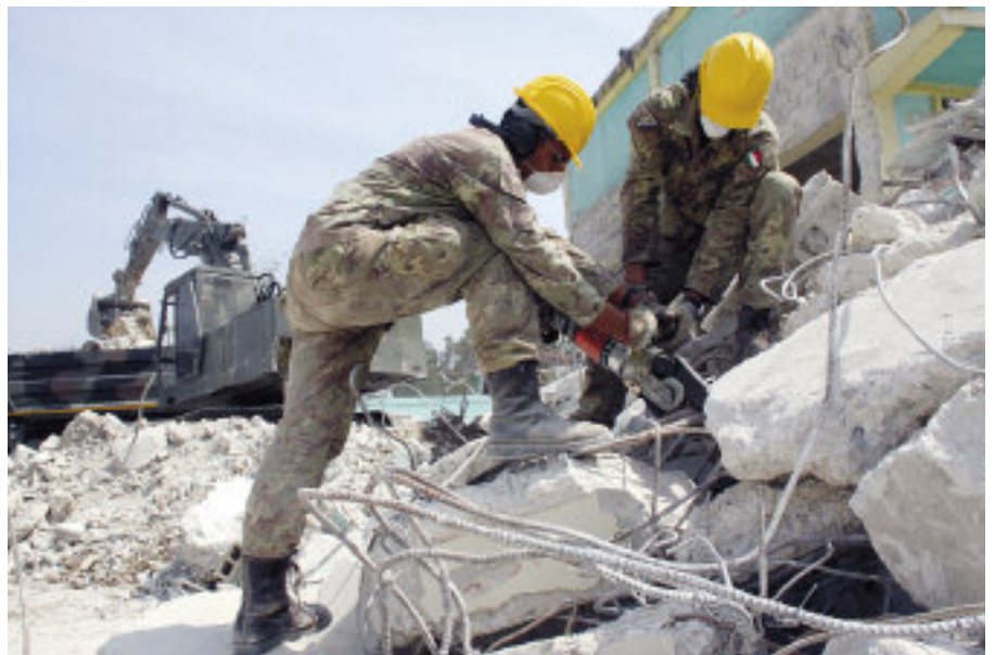
Genieri al lavoro per la rimozione di macerie. (Foto comando Truppe alpine)
